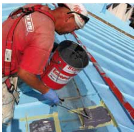
• Läpikuluttauksien rei'ät, kulkusilta- ja lumiestekiinnitykset
